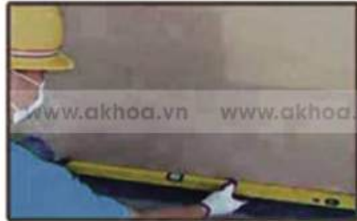
1. Đo đạc, đánh dấu, phác thảo bản vẽ lắp đặt
