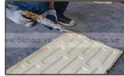
3. Dán keo vào mặt sau của tấm PU
