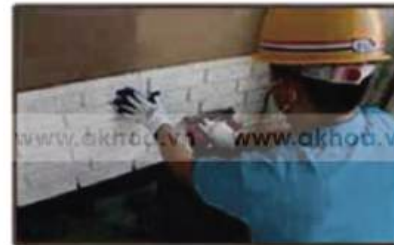
3. Gia cố tấm bằng keo và bằng súng bắn đinh
